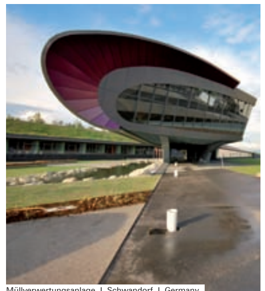
Müllverwertungsanlage | Schwandorf | Germany
