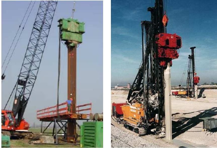
Figure 01 : Exemples d'opérations de vibrofonçage
