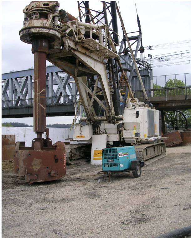
Figure 30 : Engin de forage (Becket)
