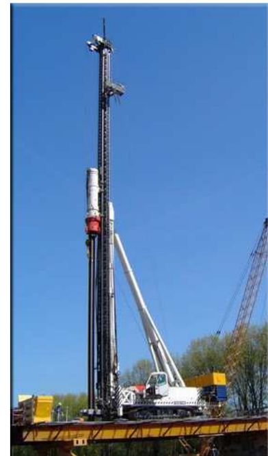
Figure 03 : Exemple d'opération de battage
