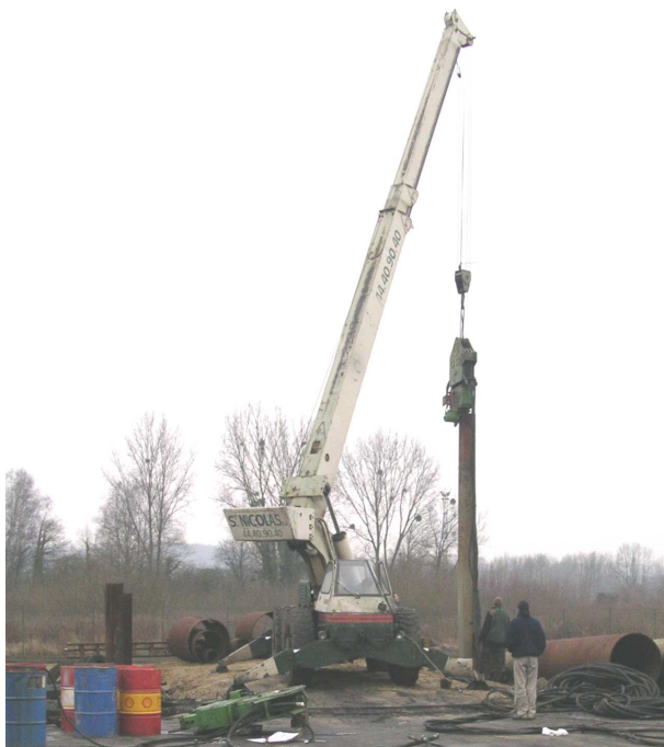
Figure 18 : Verberri / Vibrofonçeur ICE216
