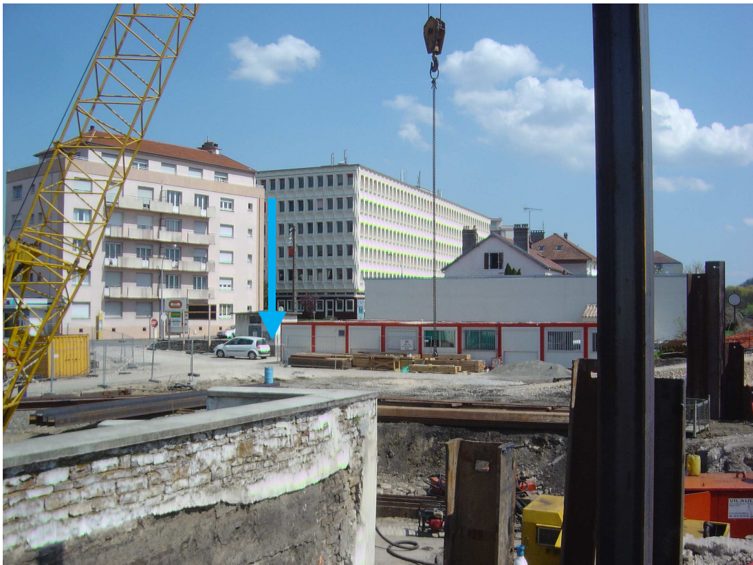
Figure 25 : vue d'ensemble du chantier
