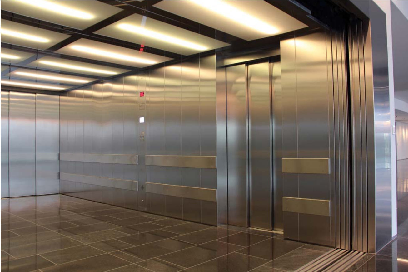
AutoLift (double piston and rated load 4.800 kg) with 3rd entrance on the side AutoLift (Doppelkolben, Nutzlast 4.800Kg) mit drei Eingängen
