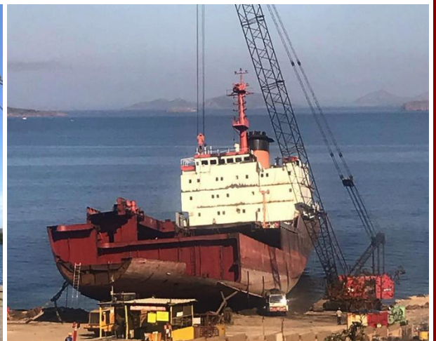
Démolition à Aliaga, août 2019. © Selim San
