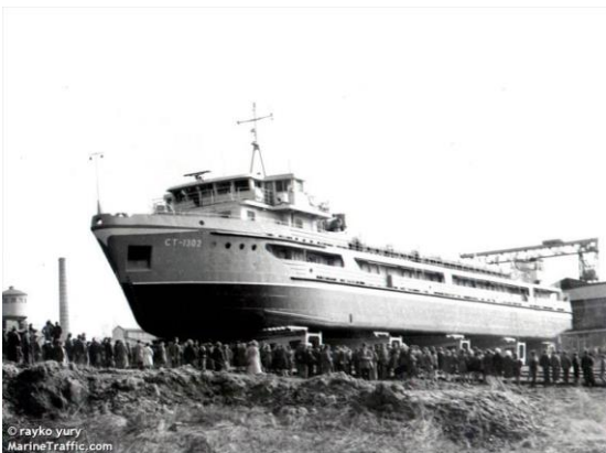
Construction du ST-1302. Collection Rayko Yury
