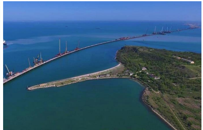
Construction du pont de Crimée
