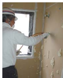
GL工法の改修
