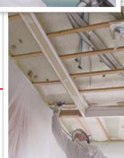
屋根・天井への断熱
