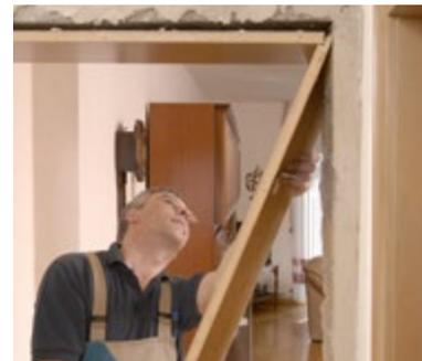
Die Tapete wird um die Bekleidung herum sauber eingeschnitten. Mit einem Stechisen wird die Zierbekleidung von der Zarge gedrückt und das Futterbrett der Zarge im unteren Drittel mit einem sauberen Schnitt durchgesägt. Danach lässt sich die Zarge problemlos ausbauen. Bei der gesamten Demontage fällt kein nennenswerter Schmutz an, da keine Stemmarbeiten oder Ähnliches erforderlich sind.
