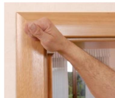
Nach dem Anpassen der Fußleiste an die neue Zargenbekleidung wird die auf Wunsch bereits im Werk zusammengebaute Zarge einfach in die Maueröffnung gestellt, ausgerichtet und mit Türspreizen fixiert. Mit speziellem Montageschaum wird die fachgerechte Montage fortgesetzt. Nach dem Aushärten des Montageschaums wird die Zierbekleidung eingesteckt, das neue Türblatt eingehängt und der Türdrücker aufgeschraubt – fertig!
