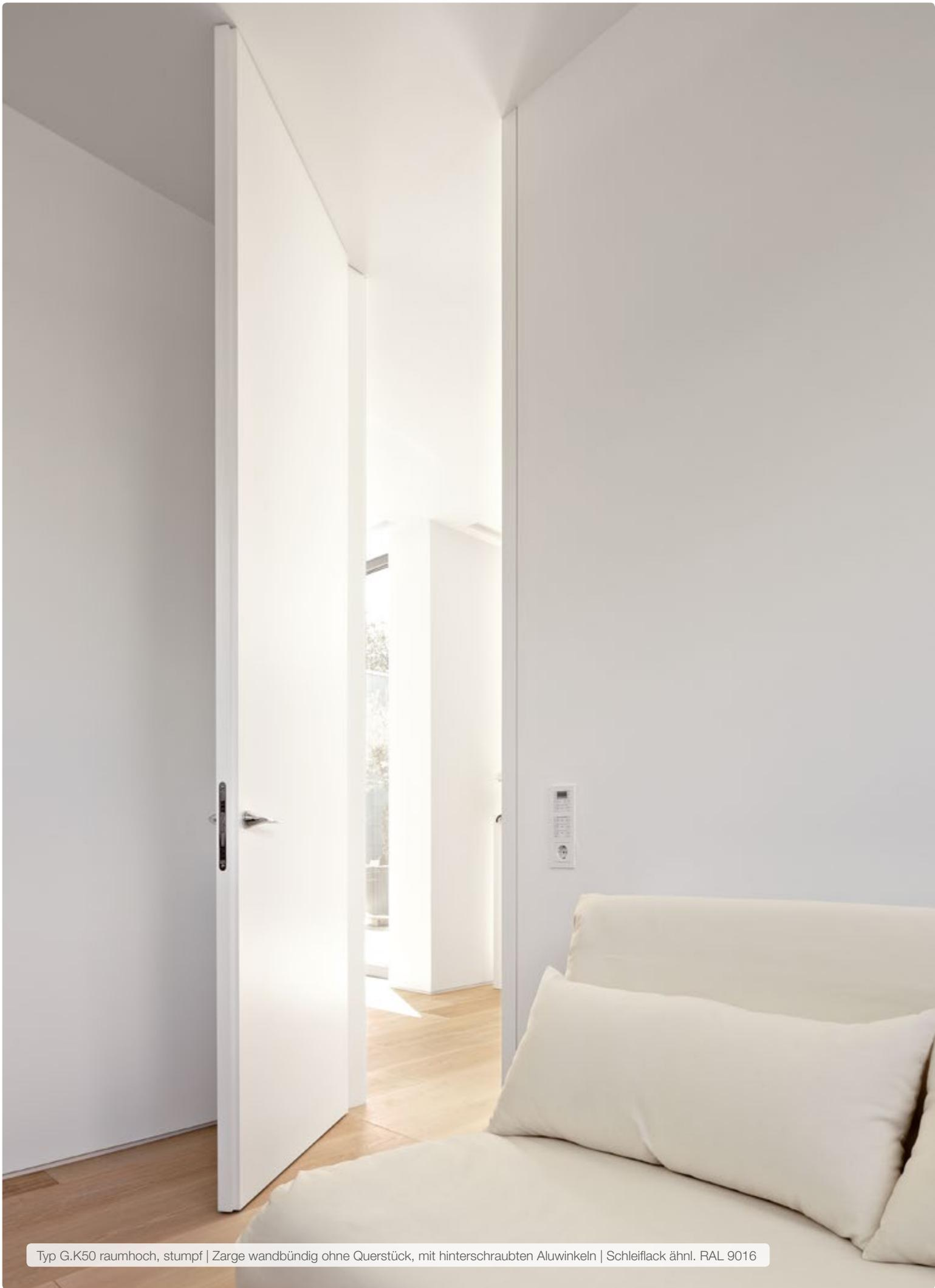
Typ G.K50 raumhoch, stumpf | Zarge wandbündig ohne Querstück, mit hinterschraubten Aluwinkeln | Schleiflack ähnl. RAL 9016
