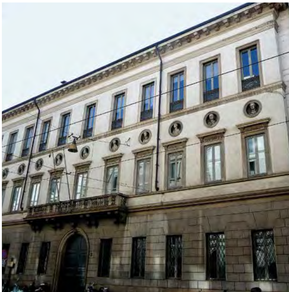
Gallerie d'Italia - Piazza Scala , Luogo: Milano - Italia, Prodotto: Atelier Réserve Siena 1348, Progetto: aMDL Architetto Michele De Lucchi, Anno: 2015 Gallerie d'Italia - Piazza Scala , Place: Milan - Italy, Products: Atelier Réserve Siena 1348, Project: aMDL Architect: Michele De Lucchi, Year: 2015 Photo: Mario Carrieri
