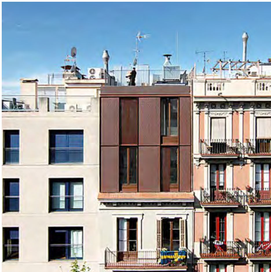
Abitazione eco-efficiente e sostenibile , Luogo: Barcellona - Spagna, Prodotto: Classica Rovere di Fontaines, Architetto: Miba architects., Anno: 2016
