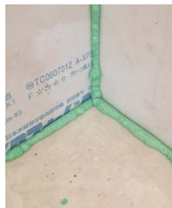
住宅基礎の防蟻処理
