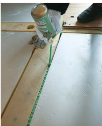
床断熱の隙間充てん・防蟻処理
