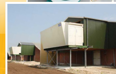
空气净化和过滤系统
