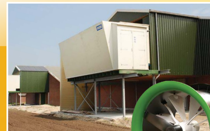
空气净化和过滤系统
