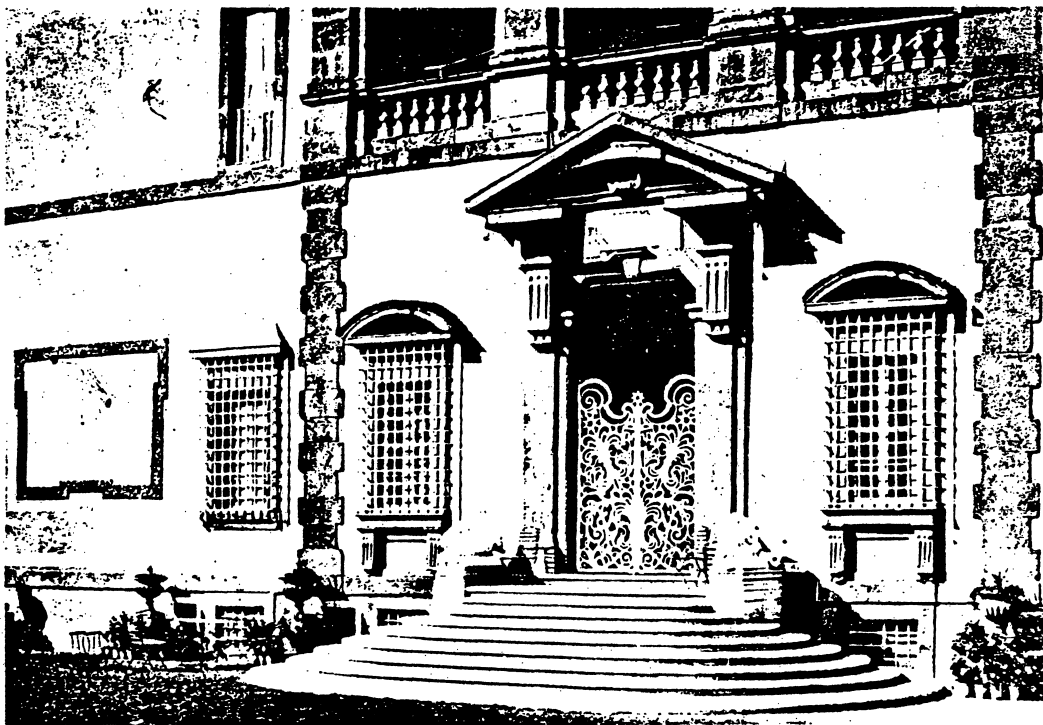
VILLA LANCELOTTI — INGRESSO AL PALAZZO.
