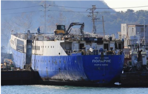
23 novembre 2019, Busan (Corée du Sud), chantier OS Shipbuilding
