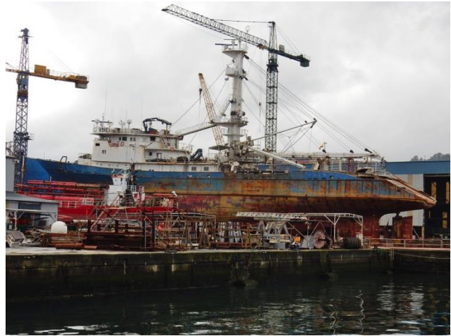
Janvier 2016, chantier de réparation, Marin (Espagne). © TYZEF29
