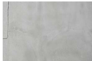
インサルクラックシャットを使用して補修後
