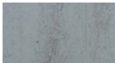
クラック補修完了
