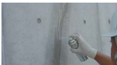
インサルクラックボンド塗布後、 インサルクラックシャットスプレーを吹き付け
