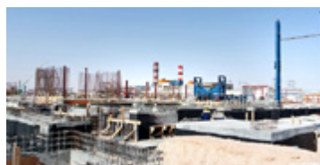
Jijel 1,300MW 联合循环电厂 工程总包：韩国现代工程建设公司
