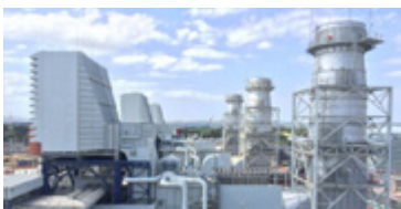
Boufarik 750MW 简单循环电厂 工程总包：土耳其GAMA
