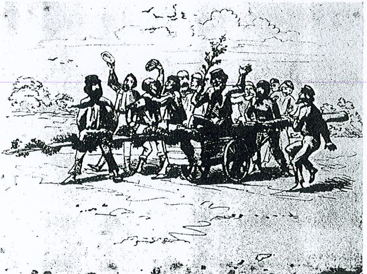
De eerste paal wordt versierd en wel naar de bouwput gebracht, voor de bouw van een huis in de P.C. Hooftstraat in Amsterdam (1872).
