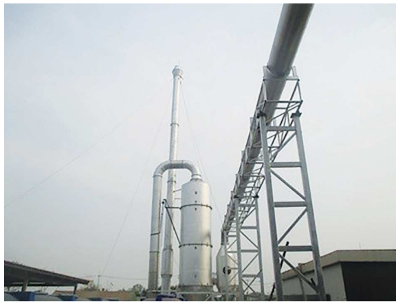
โครงการติดตั้งระบบบำบัดอากาศ Wet Scrubber ติดตั้งที่บริษัท พี.ซี.เอส.พีริซัน เวิร์ค จำกัด
