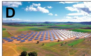
D Pozohondo solar park- 5.15 MW-Spain
