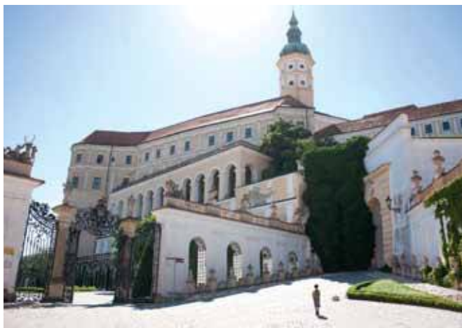
Vyhořelý a opravený. (Mikulovský zámek)
