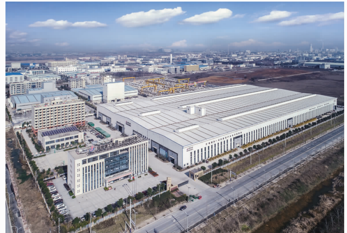
安徽建工建筑工业公司全景
