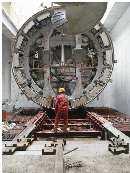
合肥轨道交通4号线4标段盾构机下井
