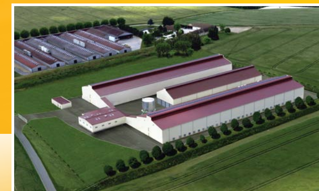
Gebäude für die Geflügelproduktion
