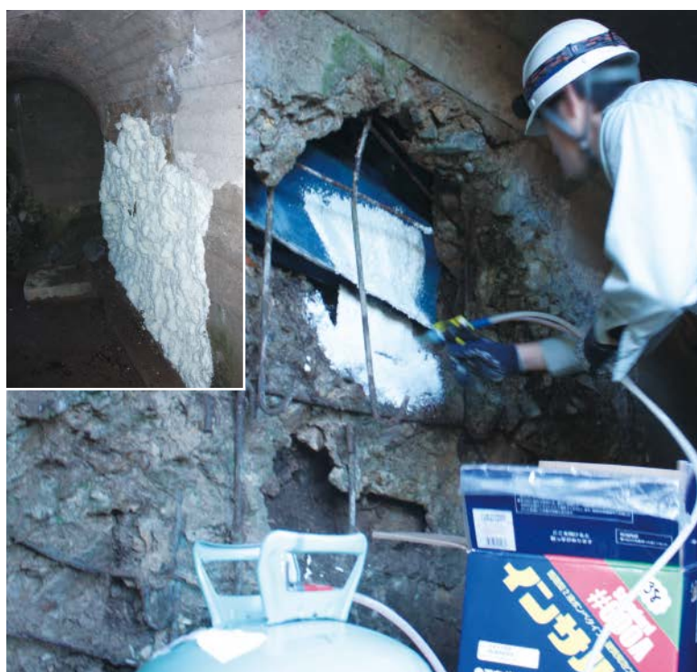
トンネル(破損部充てん)
