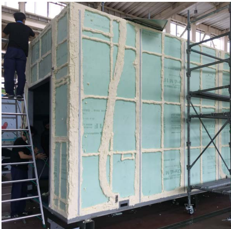
業務用冷蔵庫(冷蔵庫周りの断熱材の隙間充てん)
