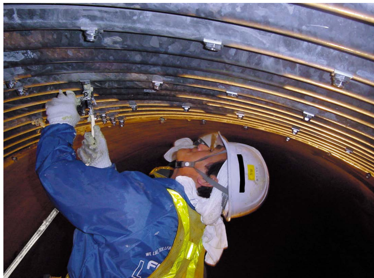
トンネル(空間裏込め)
