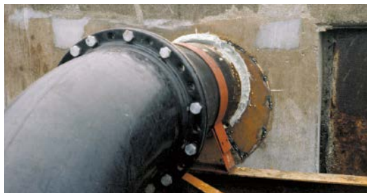
配管周り(配管の隙間に充てん)
