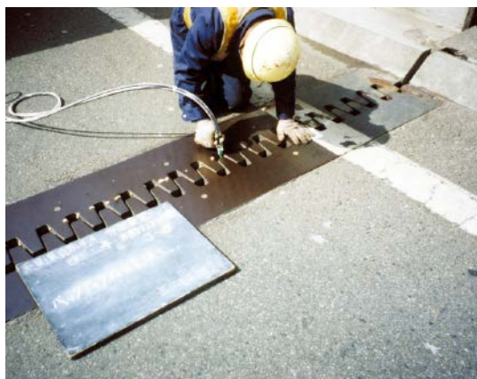
雨だれ防止(道路のジョイント部に充てん)
