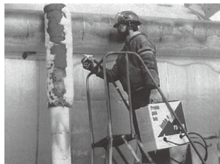
1985年当時のインサルパックによる断熱施工
