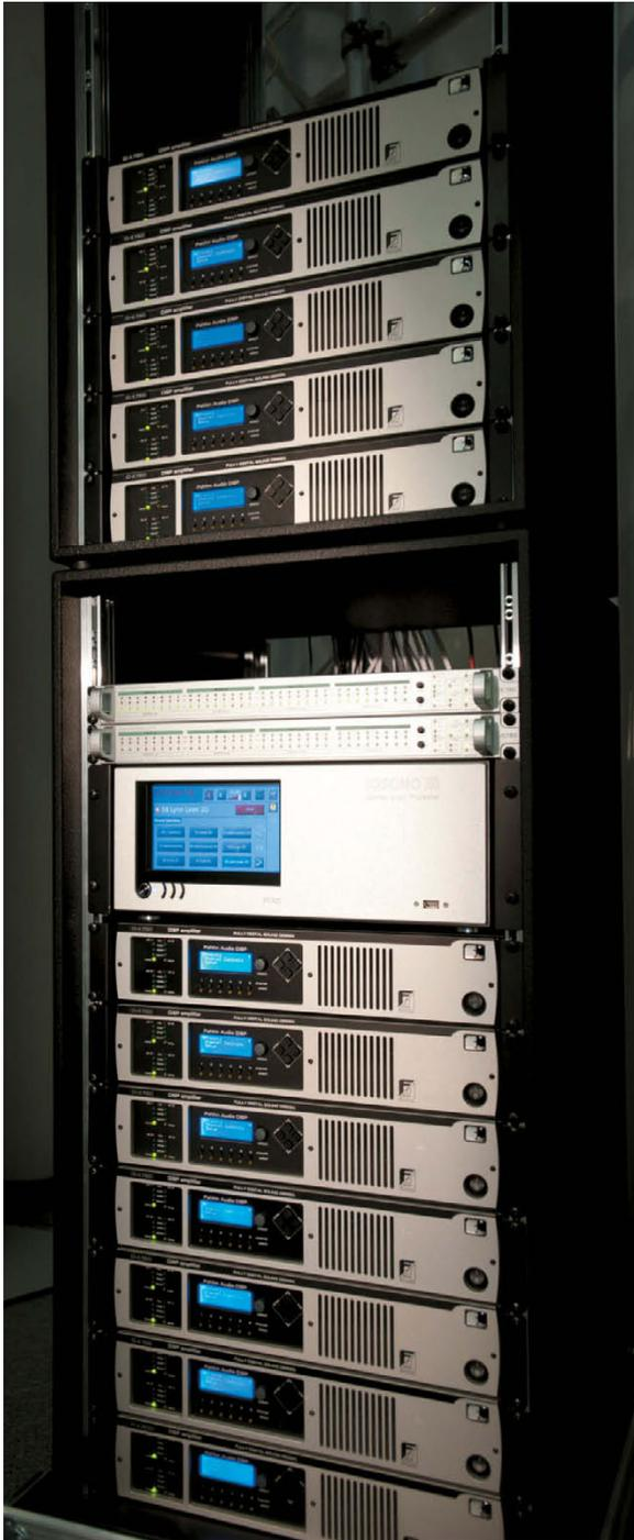
Neben Fohhn-Endstufen befindet sich im Rack nebst einigen AD/DA-Wandlern ein CORE Prozessor von IOSONO
