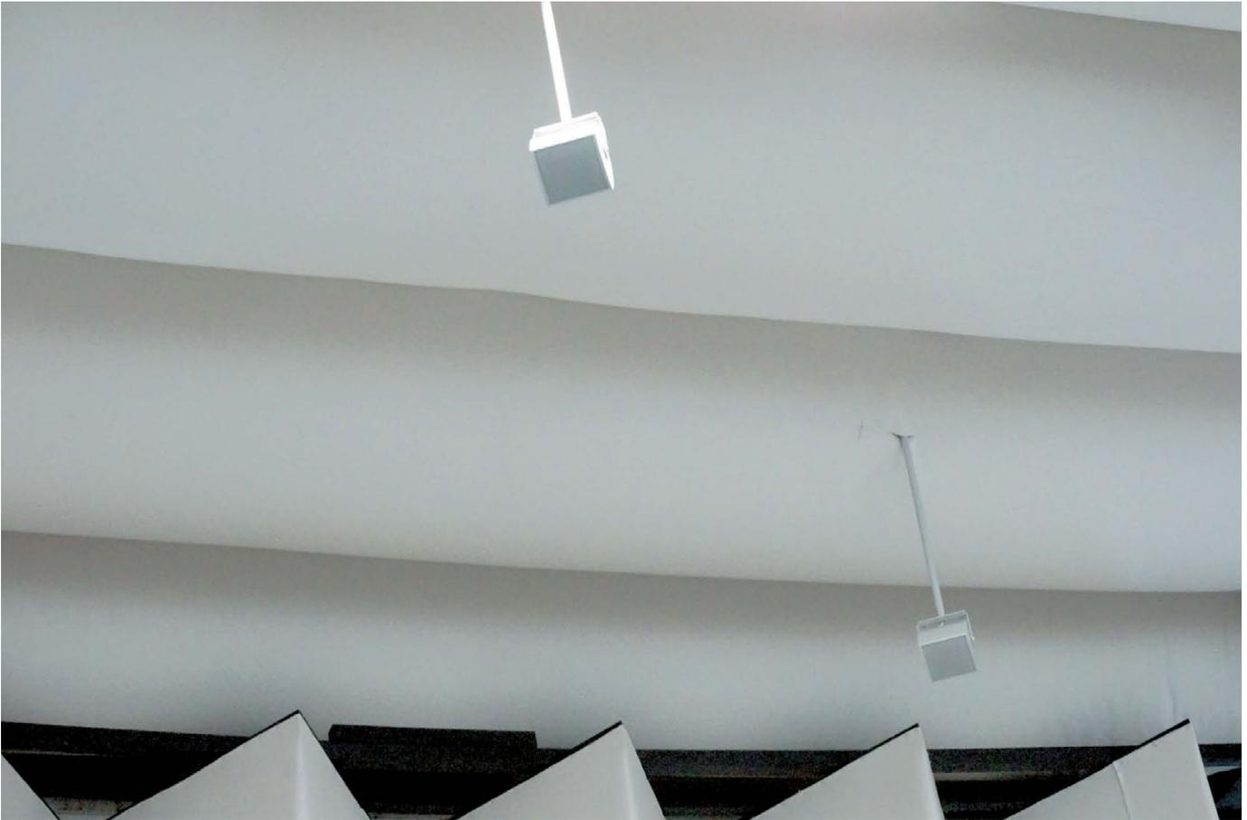
Abgehängte LX-10 Kompaktlautsprecher in 5,10 Metern Höhe über der Hörfläche
