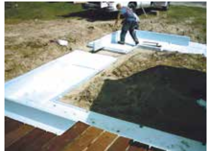
3. Placer les côtés de coffrage.
