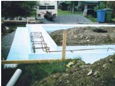
4. Déposer l'armature à l'intérieur de la semelle.
