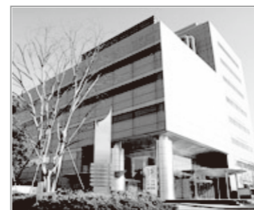
KVH東京データセンター外観
