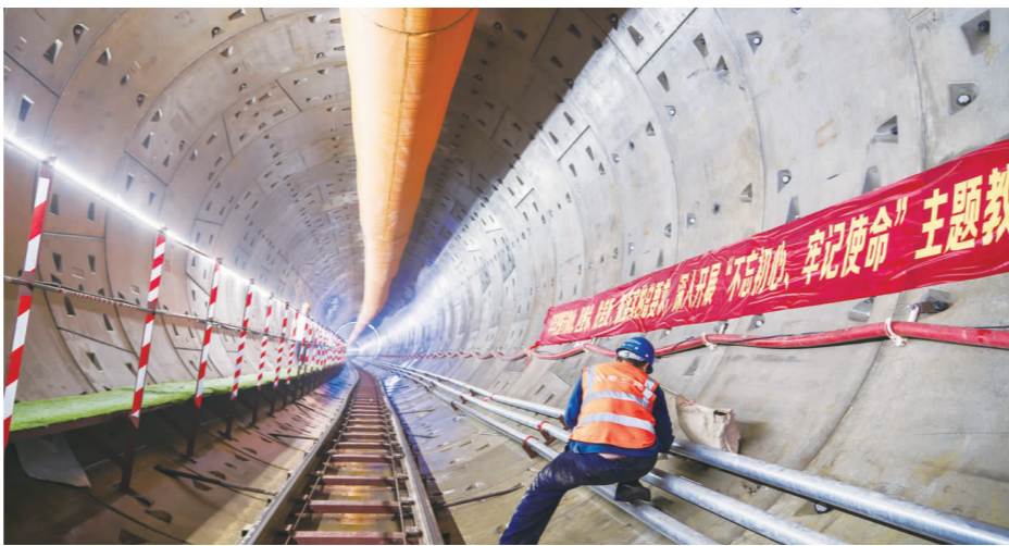
地表热浪滚滚,地下有限空间的施工同样也不轻松,合肥市轨道交通4号线4标段项目部盾构隧道里高温难耐,检修工人才工作一会,工作服已然湿透。
