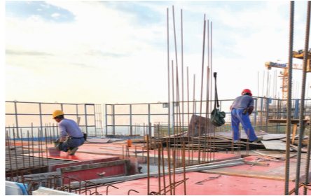
合理调整作息时间后的滨湖沁园装配式建筑项目现场,早晨五点多,项目一线工人便迎着朝霞来到项目现场为接下来的施工做准备。
