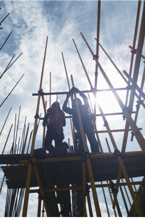
咸阳市高宝格丽三期项目顶着高温,正抢抓3#、4#楼30天完成正负零的节点工期。
