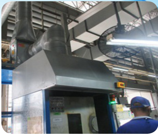
ระบบบำบัดมลพิษอากาศเตาอบชิ้นงาน
