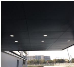
新中源豊田汽車能源系統有限公司 (STAES) (常熟工場)
