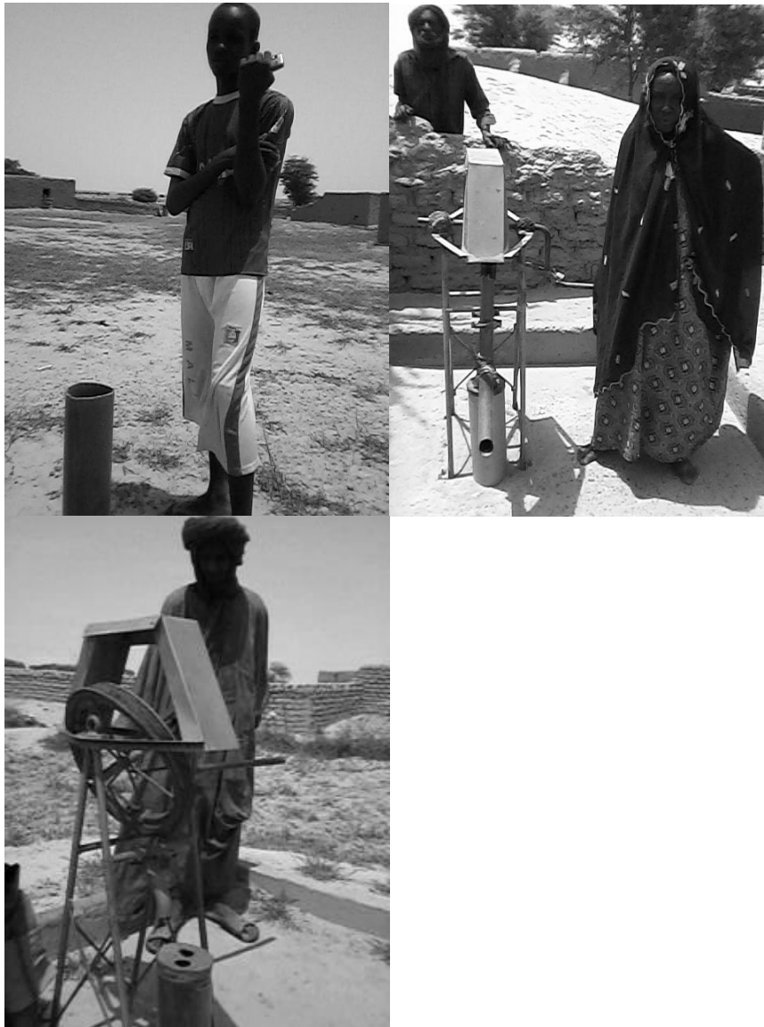
Figure 4: (a) Point d'eau à Temera, Forage manuel dont la Pompe à Corde est emporté et vandalisée (gauche); (b) Point d'eau à Temera, Pompe à Corde dont la corde et les roulements sont cassée (milieu), Point d'eau à Bamba, Pompe à Corde vandalisée (gauche)
