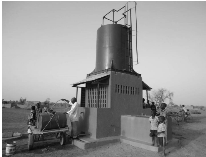
Poste d'eau autonome à la périphérie de Ouabigonya (Burkina Faso). Coût : environ 15 millions F CFA sans le forage.
