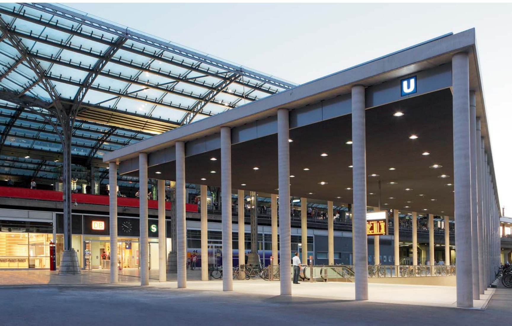
Metro station Breslauer Platz, Köln (D). Architect: Architekturbüro Bueder + Wenzel Architekten, Köln. Lighting design: Licht Kunst Licht, Bonn/Berlin.
