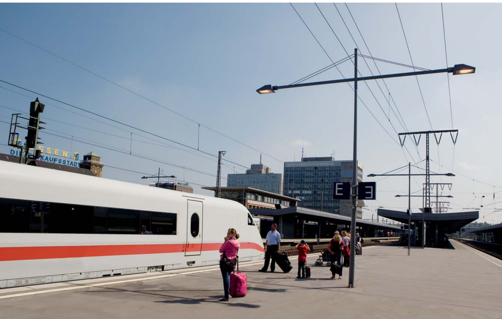
Main station. Essen (D)
