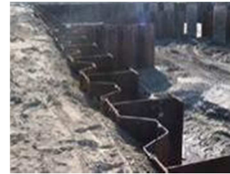
Figure 9 Exemple de rideaux mixtes HZ. Source: ArcelorMittal
