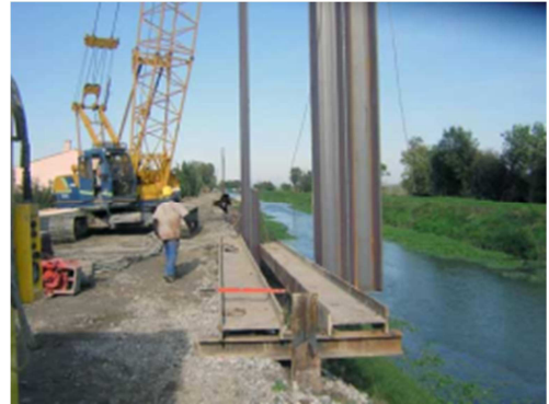
Figure 20 Guide palplanche à 1 niveau sur le chantier de la rive droite du Viqueirat (Arles)
