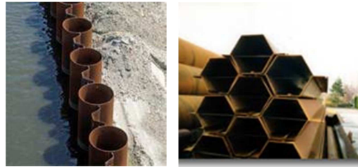
Figure 8 Exemples de rideaux mixtes tubes et de caisson. Source: ArcelorMittal Ecluse, Evergem, Belgique
