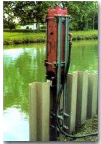
Figure 12 Mise en place de palplanche PVC. Source Altifer.com
