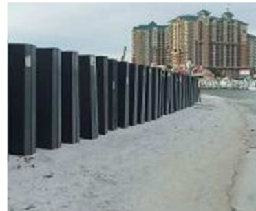
Figure 14 Rideau de palplanche en fibre de verre. Source : ilinternational.nl
