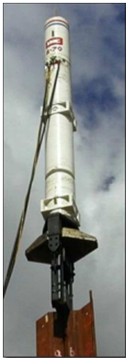
← Figure 22 Mouton hydraulique. Source : IHC.fr
