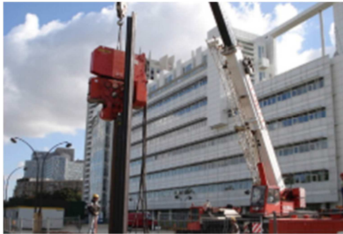
←Figure 28 Exemple de vibrofonçeur à haute fréquence à moment variable monté sur une grue télescopique. Source : PTC-Fayat Group
