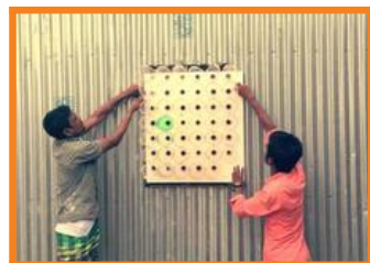
L'air chaud qui entre dans chaque bouteille est compressé au niveau du goulot, ce qui le rafraîchit avant qu'il n'entre dans la pièce.
