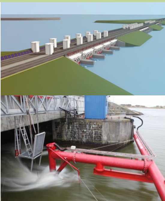
Den Oever (オランダ) における 100kW タービンの運営状況 (写真: Tocardo 社提供)
