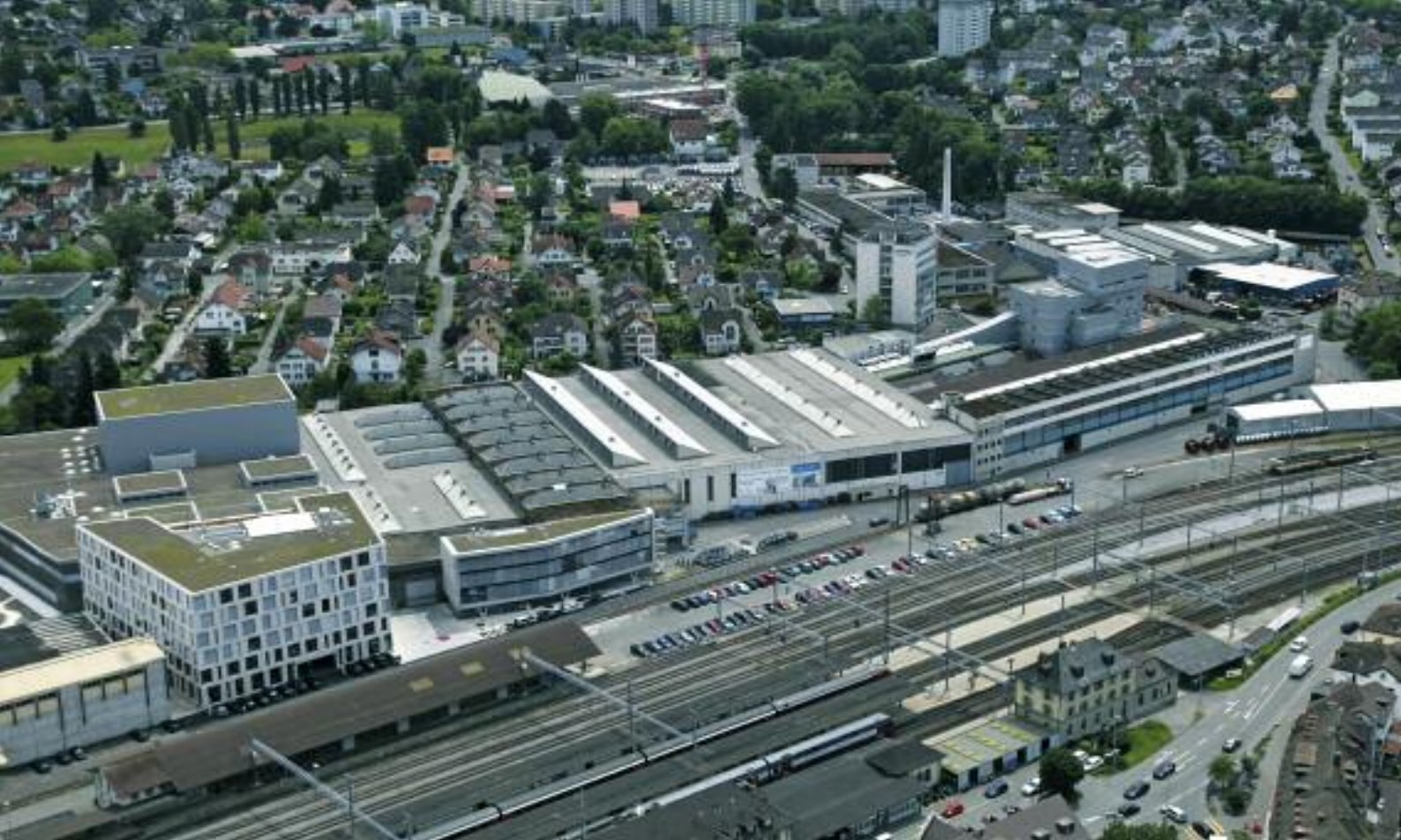
Konzernsitz und Brugg Kabel AG Head office and Brugg Cables Ltd, Brugg
