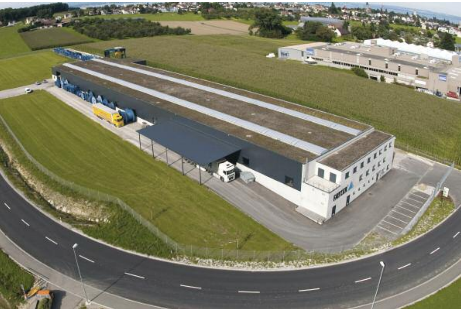
Neubau Fatzer AG New factory Fatzer Ltd, Romanshorn
