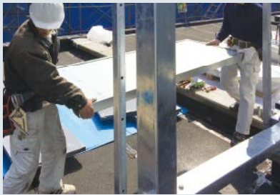
①パネルを現場に搬入します。パネルは人の手 で容易に運ぶことができます。
