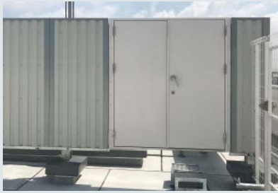
④開口部には防音ドアを設置します。
