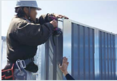
⑤コーナー部は専用コーナー金物で固定します。
