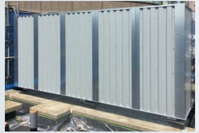
⑥すべてのパネル取り付け後、必要に応じて パネル間にコーキング処理をしてください。
