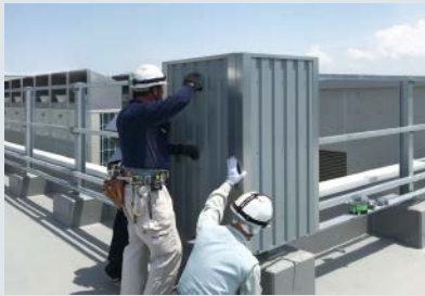
②パネルを鉄骨フレームに仮置きし、パネル 取り付け位置を決定します。
