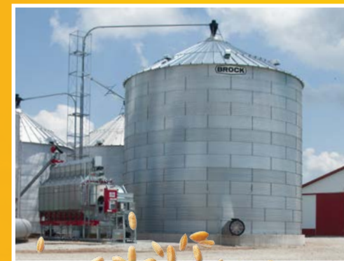
Instalaciones para granos en la granja
