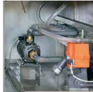
Centrifugal pump for adiabatic cooling Axiale Kreispumpe für adiabate Kühlung Pompa centrifugale per raffreddamento adiabatico
