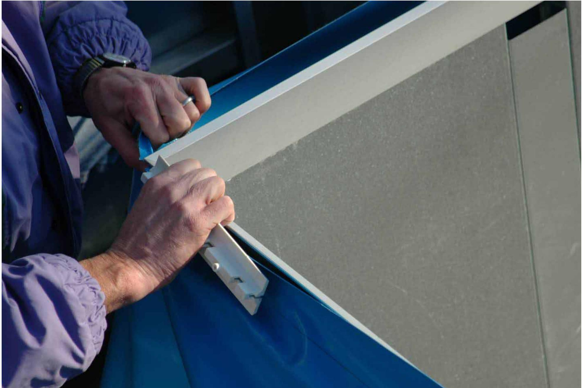
5.3 successivamente applicare un aggancio ogni 2 metri circa lungo tutto il perimetro della piscina, in modo da distribuire correttamente il canale prima del fissaggio finale del perimetro.
