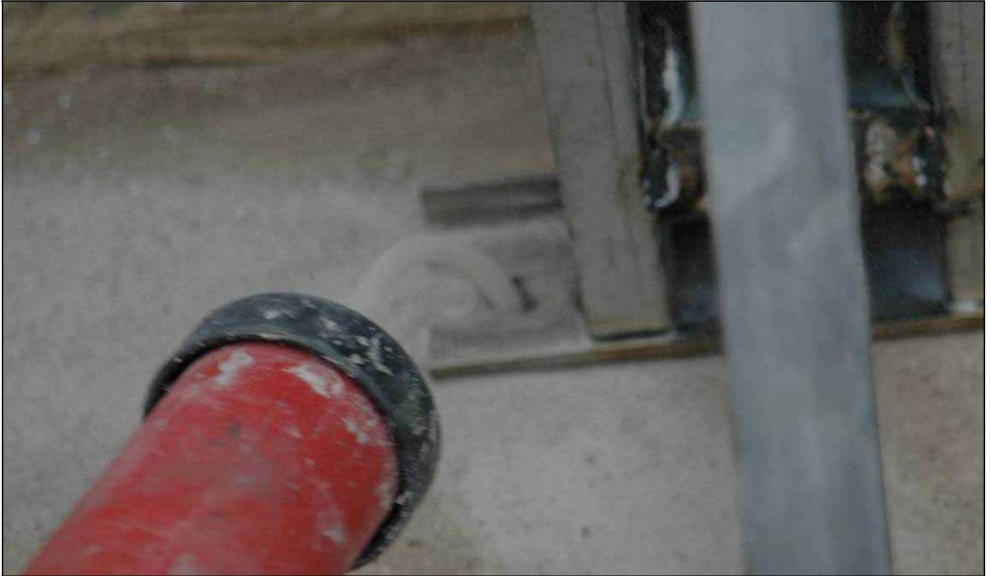
2.10 Iniettare la resina e inserire lentamente la barra filettata ruotandola in senso orario per evitare che la colla fuoriesca troppo dal foro.
