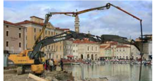
Betoniranje pod vodo - podaljšek roke omogoča betoniranje v večjih globinah (na večji oddaljenosti od obale)
