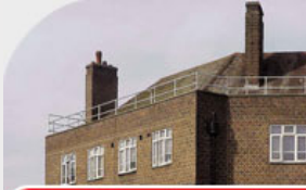
Roof Edge Protection
